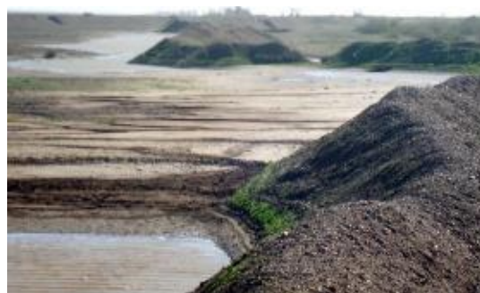
شکل ۱۸. تجمع رسوبات بالادست در پشت خاکریزها
