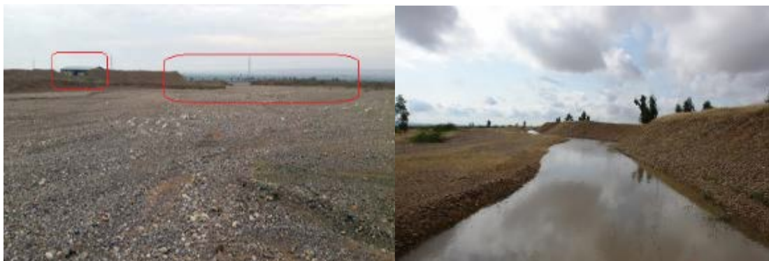
شکل ۱۶. تمرکز جریان‌های سطحی در پشت خاکریزها
