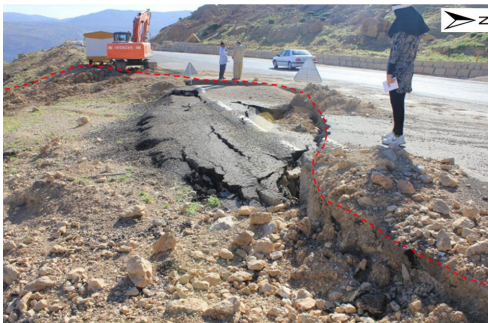
شکل ۱ عکس میدانی - نمونه ای از زمین لغزش حادث در مجاورت خط لوله
