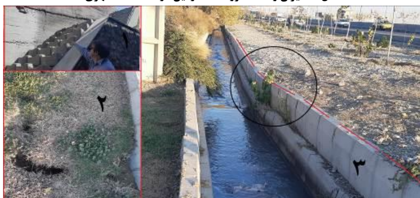
شکل ۶: نمونه‌ای از آثار احتمالی فرورنشست زمین بر ابنیه مختلف منطقه مورد مطالعه
